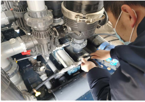
图 6 柱塞泵安装
